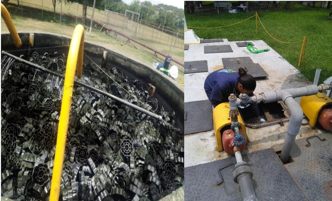
**Ilustración 4 filtro percolador y tanque Imhoff**
