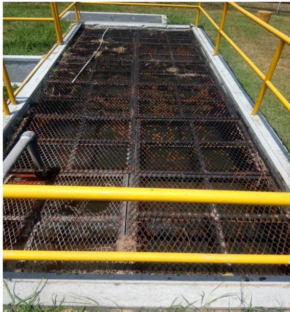
**Ilustración 3 sedimentador siguiente al filtro percolador**
